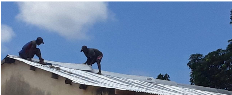
Dach-Reparatur des Klassenraumes der Vatambe Grundschule durch SEED
