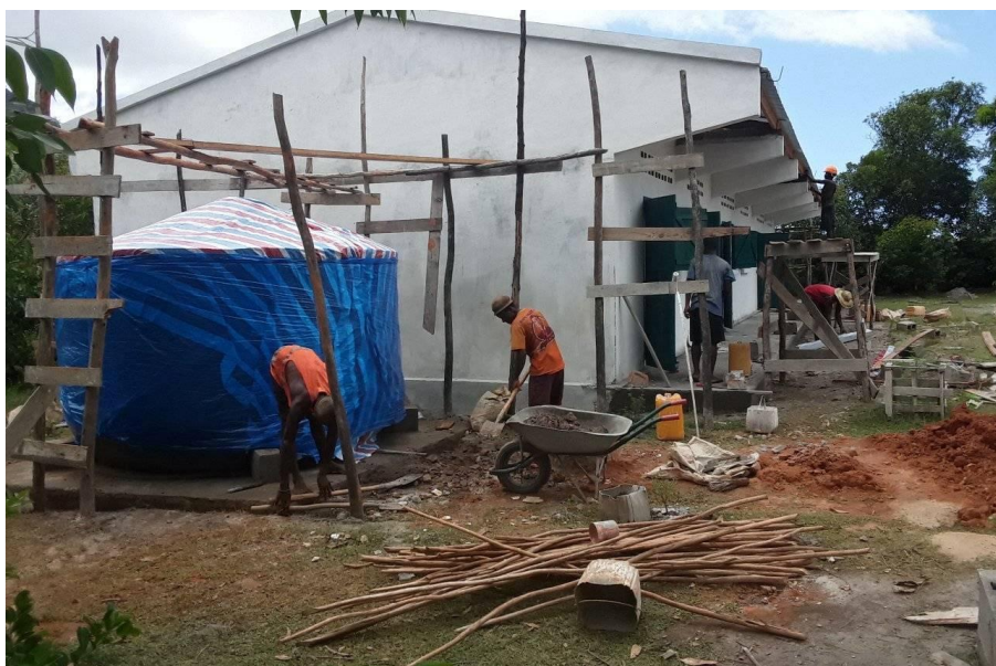
Der Aufbau der drei neuen Klassenräume und der Regenwasser-Auffangananlage in Vatambe
