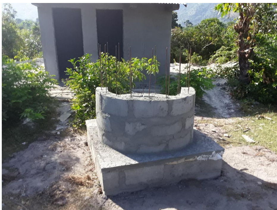
Das Fundament einer Handwäsche-Anlage der Vatambe Grundschule
